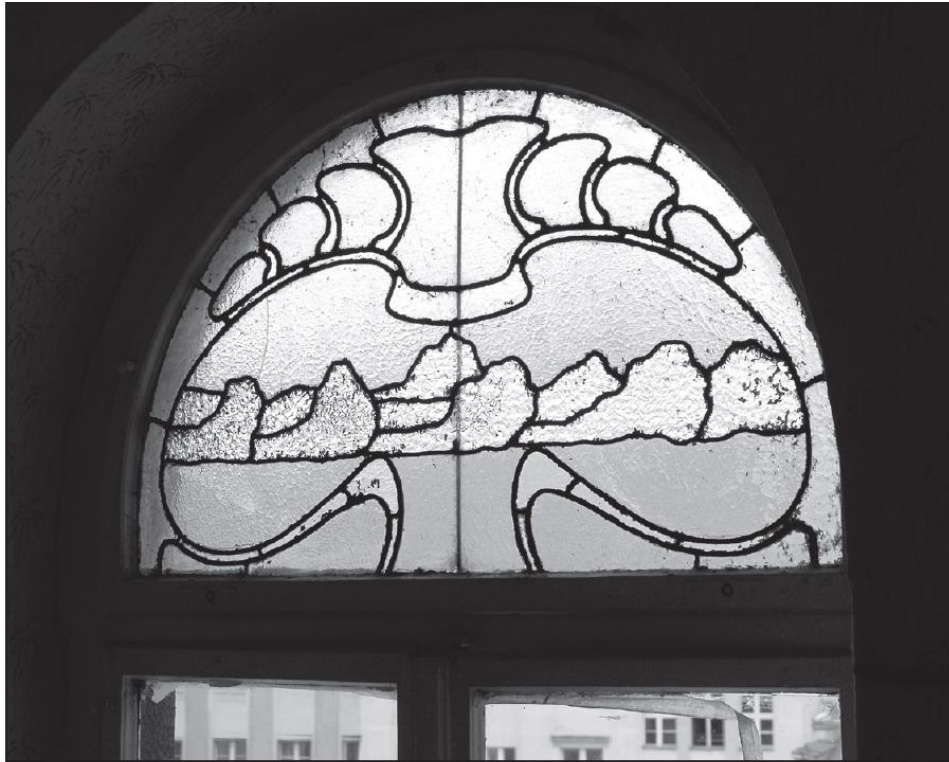
Witraż z motywem chmur w klatce schodowej budynku, 1903 (fot. Lech Dominik)
